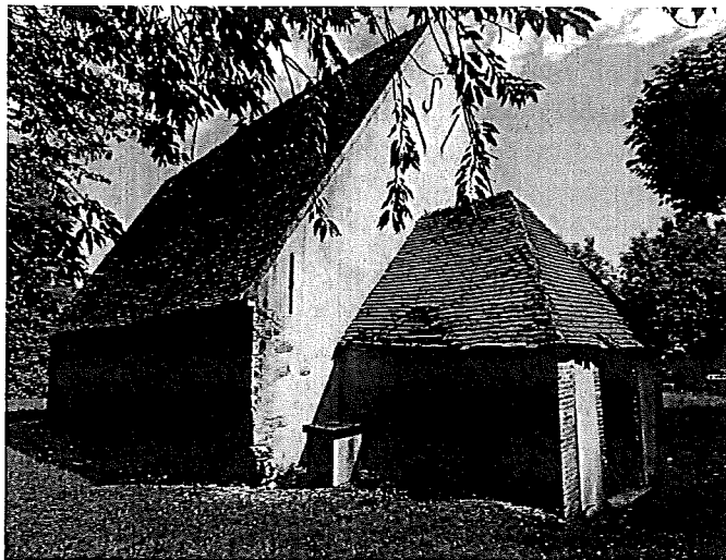
Figure 2 : La chapelle Saint Leonard rénovée, Les Clérimois (Yonne)
